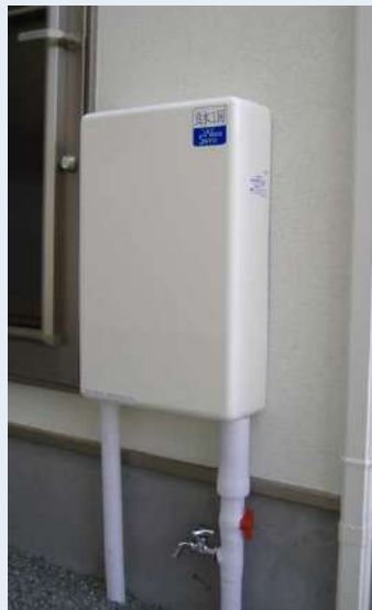
屋外の外壁に取付
