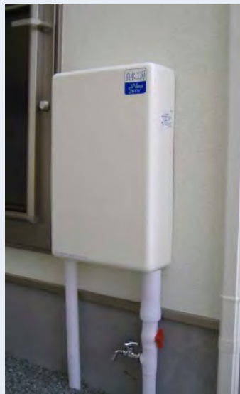
屋外の外壁に取付
